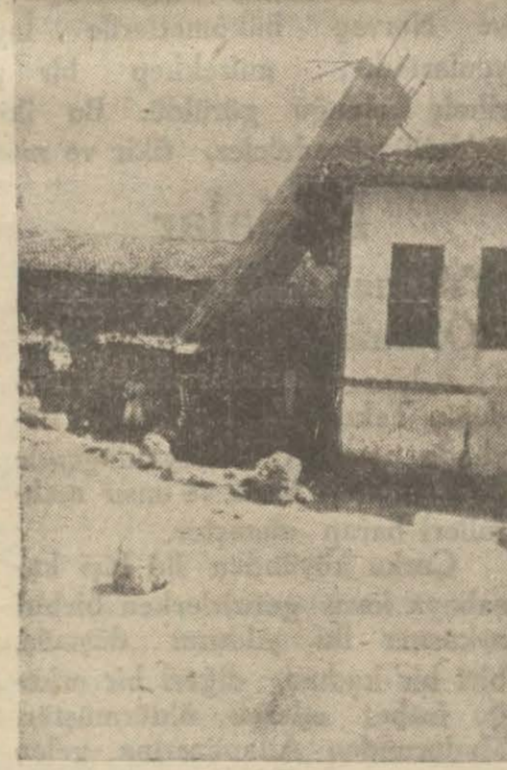
Akpınar caminin yıkılan minaresi
